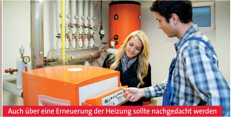
Sind die Fenster alt oder undicht, geht unnötig Energie verloren
